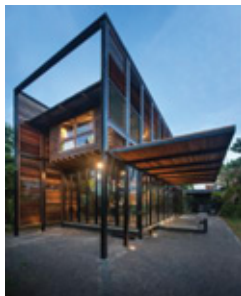
โครงการ Pasang และการออกแบบแผงบังแดดเพื่อป้องกันความร้อนจากแสงอาทิตย์บริเวณช่องเปิดของอาคาร
