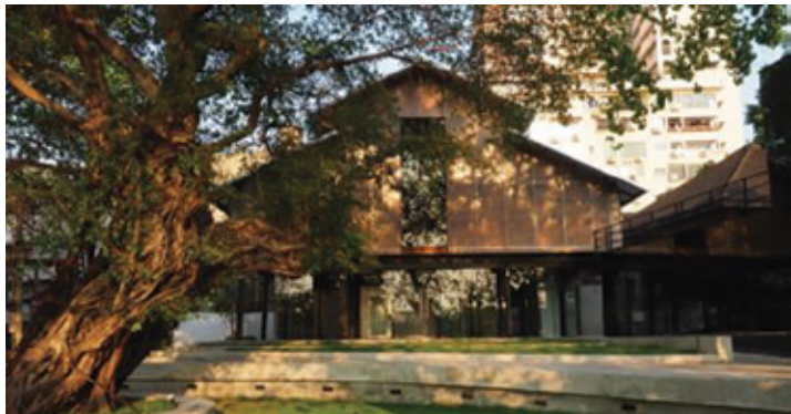
โครงการ PUEY UNGPACHORN ARTISTIC PARK และอาคารหลักของโครงการที่ปรับปรุงจากอาคารเก่าริมแม่น้ำเจ้าพระยา
