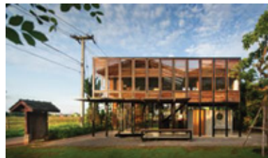
โครงการ Pasang และการออกแบบแผงบังแดดเพื่อป้องกันความร้อนจากแสงอาทิตย์บริเวณช่องเปิดของอาคาร
